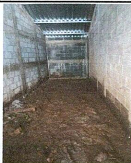
Foto 3: A vance de trabajos en suministros e instalación de estructura metalica y lamina.
