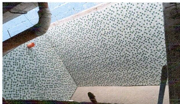
Foto 4: Instalación de azulejo parte interior.
