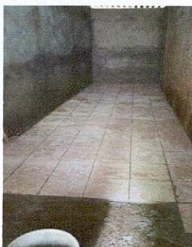
Foto 5: avance de trabajos en suministro e instalacion de piso ceramico.
