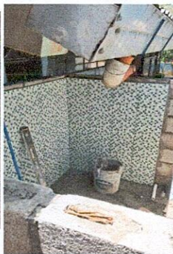
Foto 3: Culminación de pared de tanque e iniciación de colocación de azulejo.
