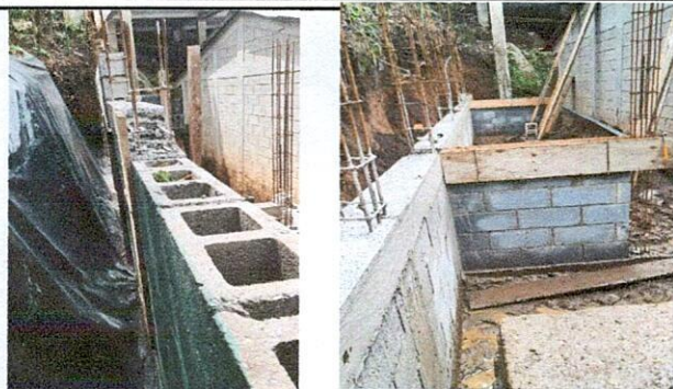
Foto1: Avancce del suministro e instalación de pared de block y columnas.
