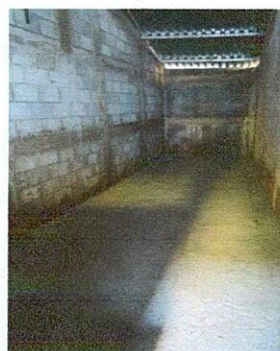
Foto 4: Finalización de la instalación de lámina y piso de concreto
