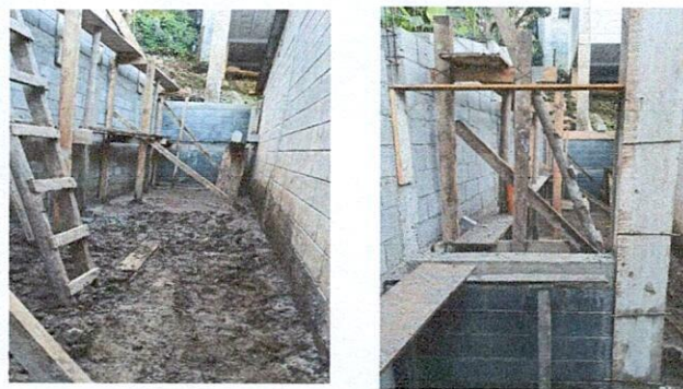
Foto 2: Finalización de las paredes de block y columnas
