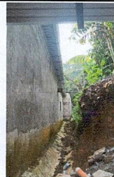
Foto 6: Colocación de agarradores e instalación de canal de agua pluvial.
